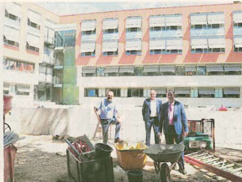
Die Bauarbeiten für das neue provisorische Krankenhausgebäude laufen. Unser Bild zeigt von links Vize-Landrat Franz Clemens Brechtel, Stiftungsdirektor Marc Engelhard und Baukoordinator Christian Pröll. Foto: Bigelmayr
