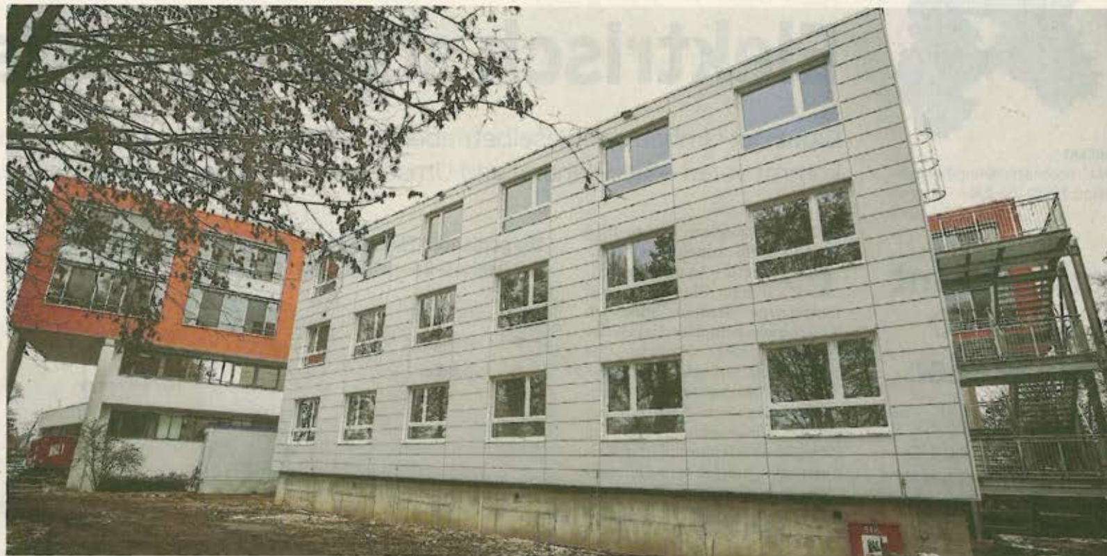
Das Modulgebäude ist fertig, die Behandlungsräume im Erdgeschoss gehen bald in Betrieb.
