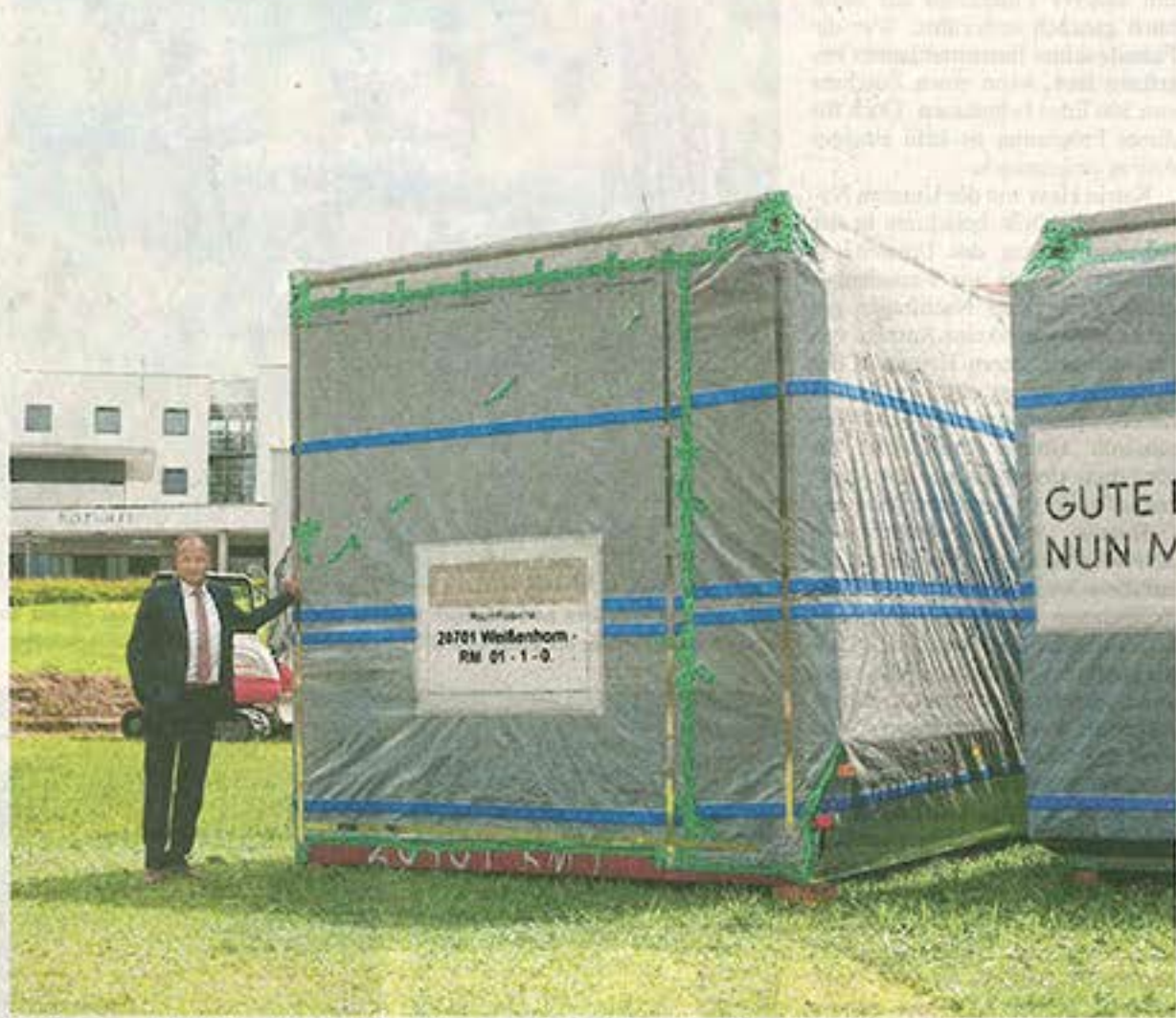
Die Container sind da: Mit solchen Modulen wird in den nächsten Wochen der Anbau für die Stiftungsklinik in Weißenhorn hochgezogen. Links im Bild: Stiftungsdirektor Marc Engelhard.
