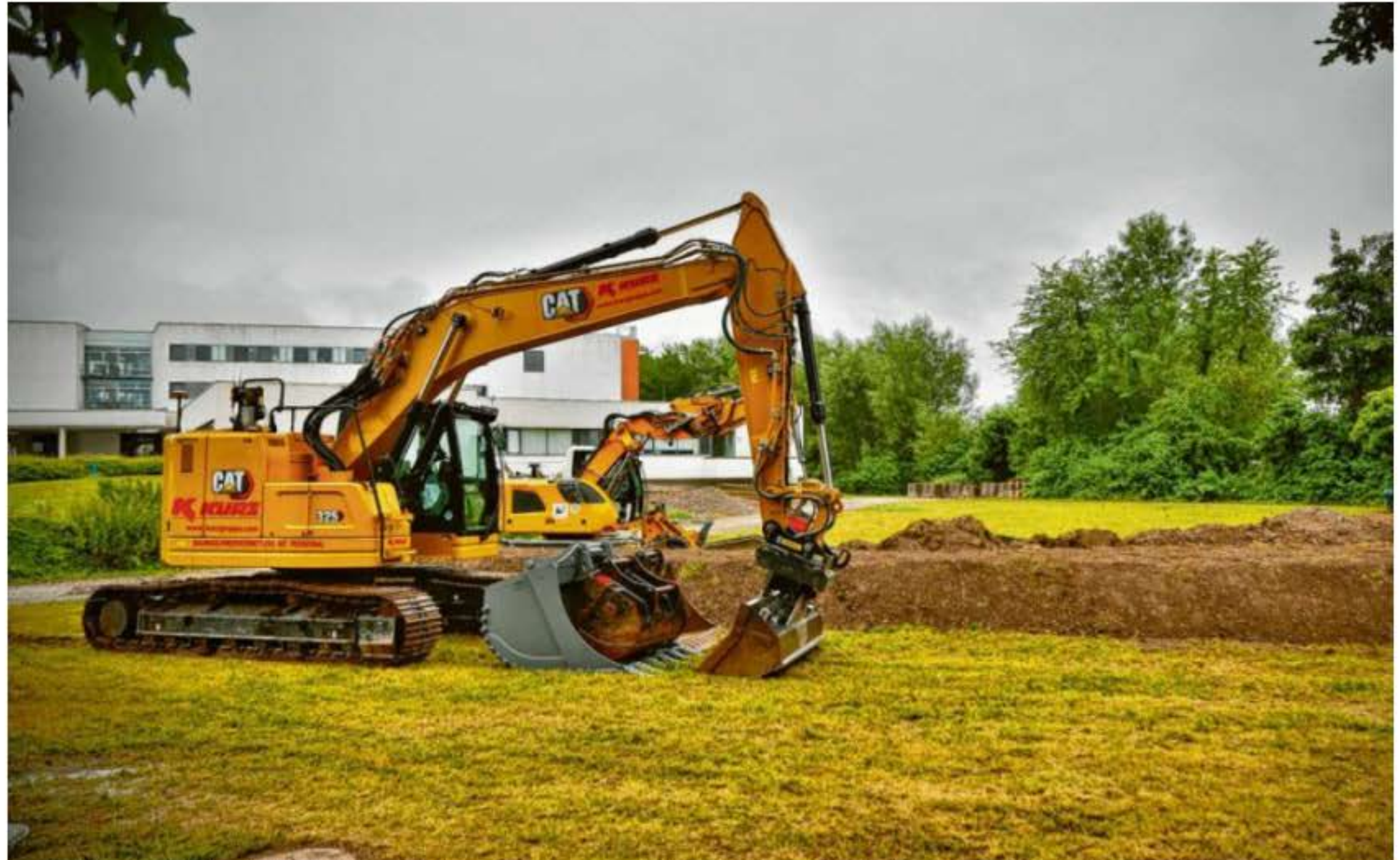
Im nördlichen Bereich des Klinikgeländes in Weißenhorn wird eine neue zentrale Aufbereitungseinheit für Medizinprodukte, kurz AEMP, gebaut. Fotos: A. Kaya
